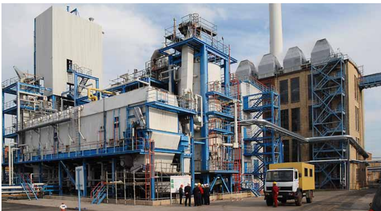
Stoffliche Nutzung von Braunkohle mit beinahe 100-jähriger Tradition: Die Rohmontanwachsgewinnung durch Extraktion bei ROMONTA am Standort Amsdorf (Foto G. Saray).
